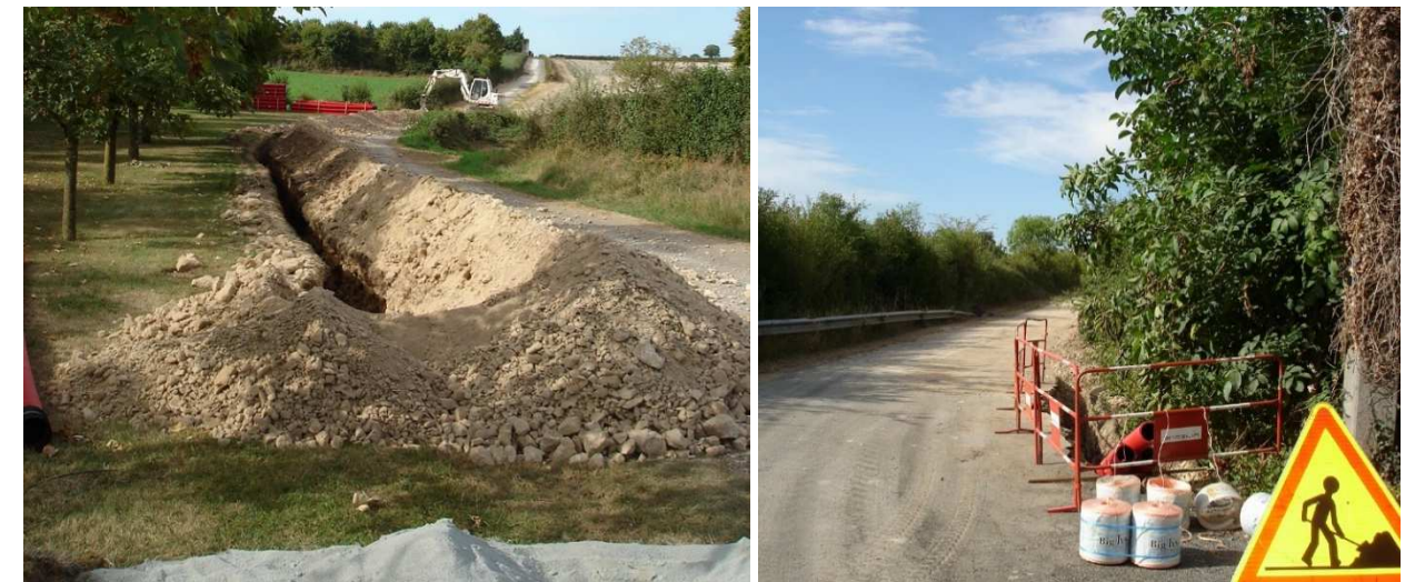
Figure 5 : Exemple de travaux de raccordement au réseau public de distribution (source : VALOREM, 2015)
